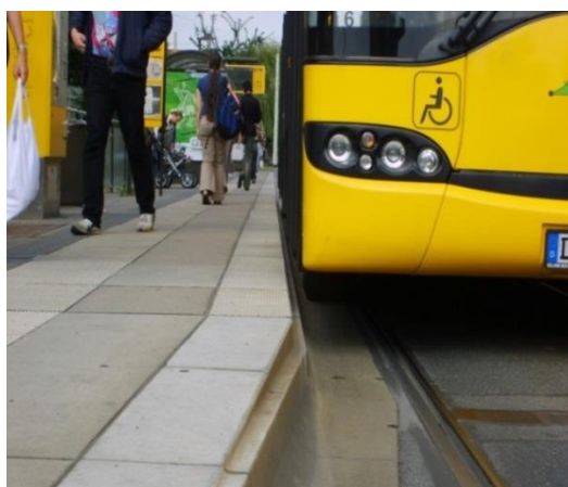
Rys. 7.1. Zalecane ukształtowanie krawędzi peronowej.
