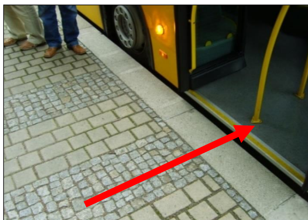
Rys. 7.3. Strefa wejściowa – inny rodzaj nawierzchni naprzeciwko pierwszych drzwi autobusu.
