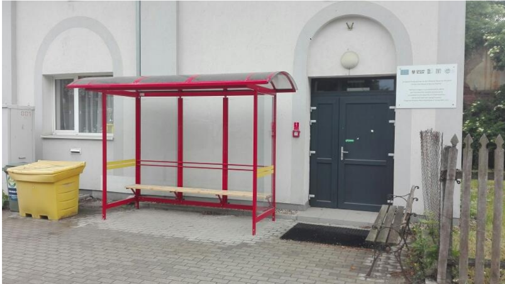
Wiaty przystankowa Gądów przy świetlicy
