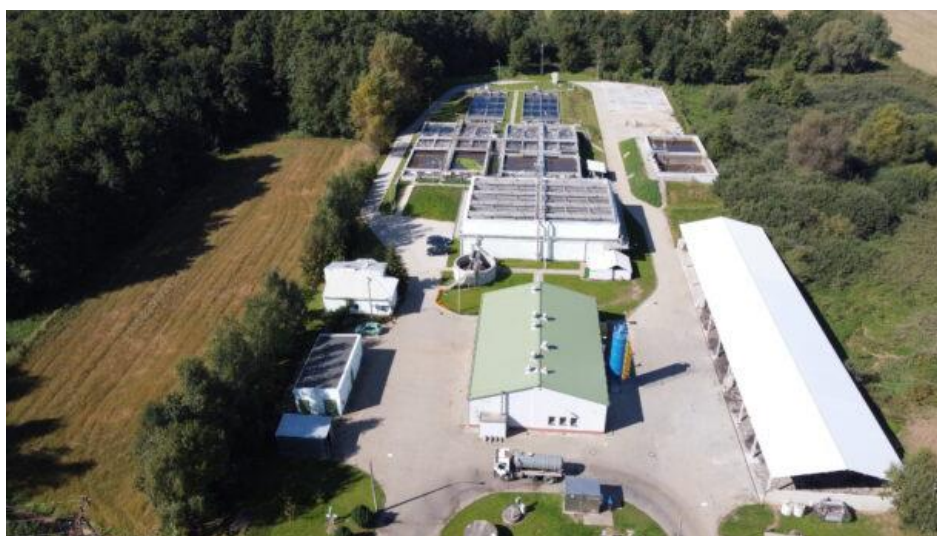
Komunalna oczyszczalnia ścieków w Jurczycach
