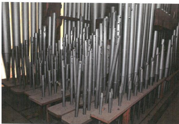
Piszczałki sekcji I i II manuału przed demontażem
