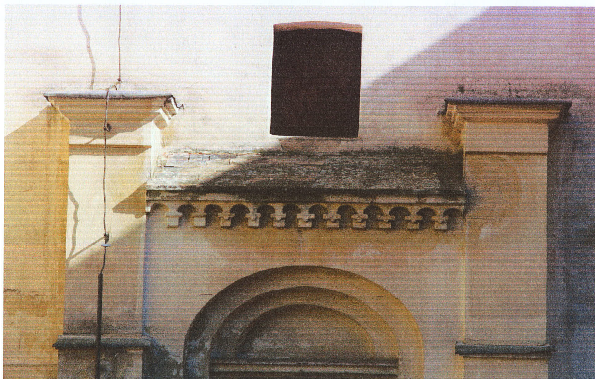
7.6. detal gzymsu krenelażowe portalu wejściowego wieży, fot.09
