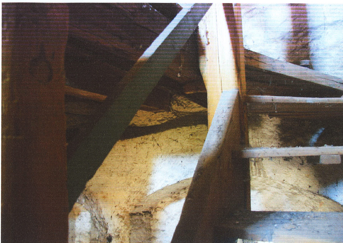
7.23. schody- pochwyty i poręcze , fot.59, fot.60
