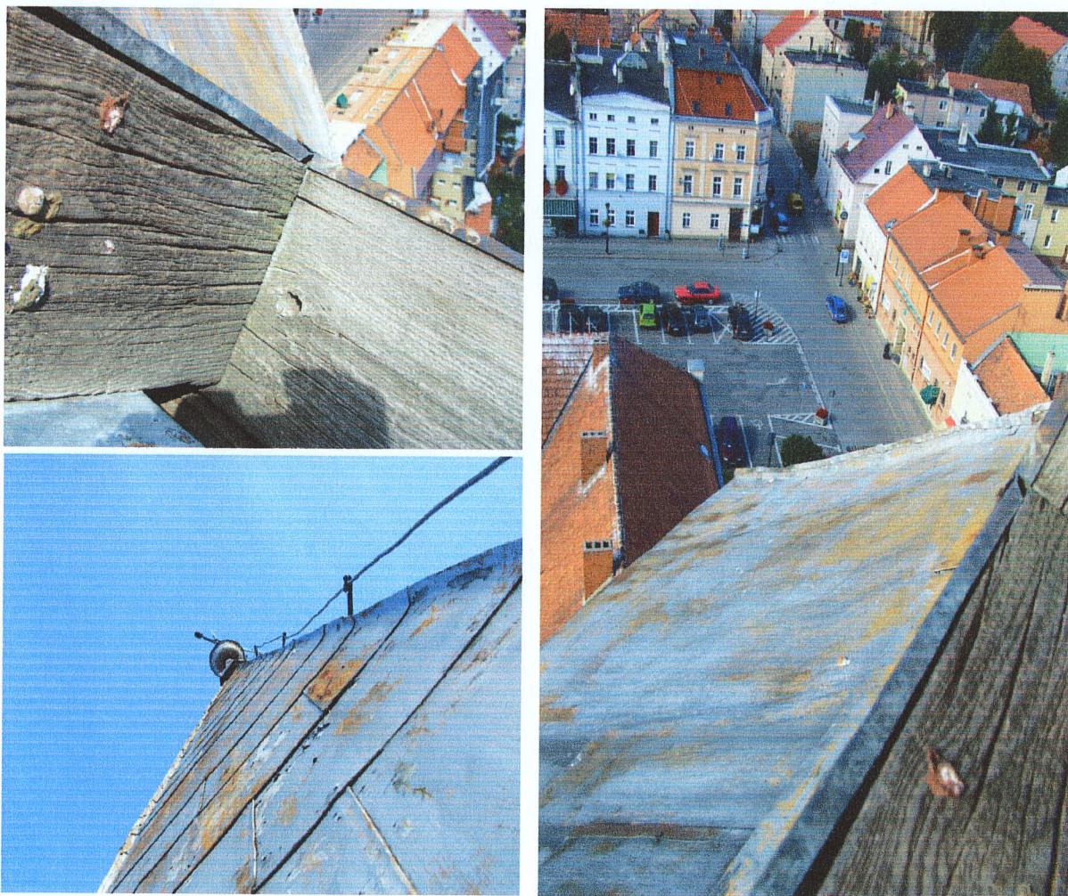
7.11. detale helmu wieży, fot.24, fot.25, fot.26
