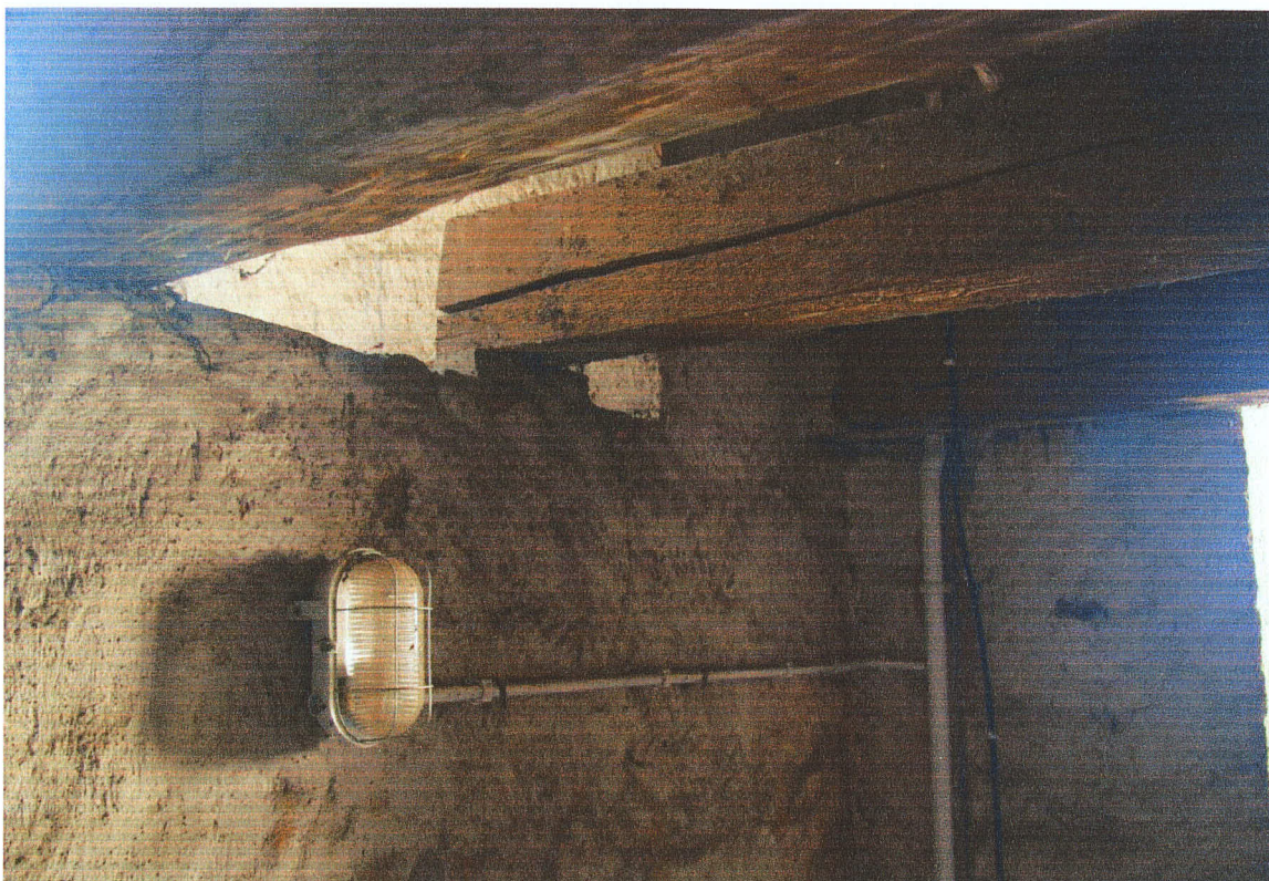
7.24. schody- belki stropowe, fot.61, fot.62
