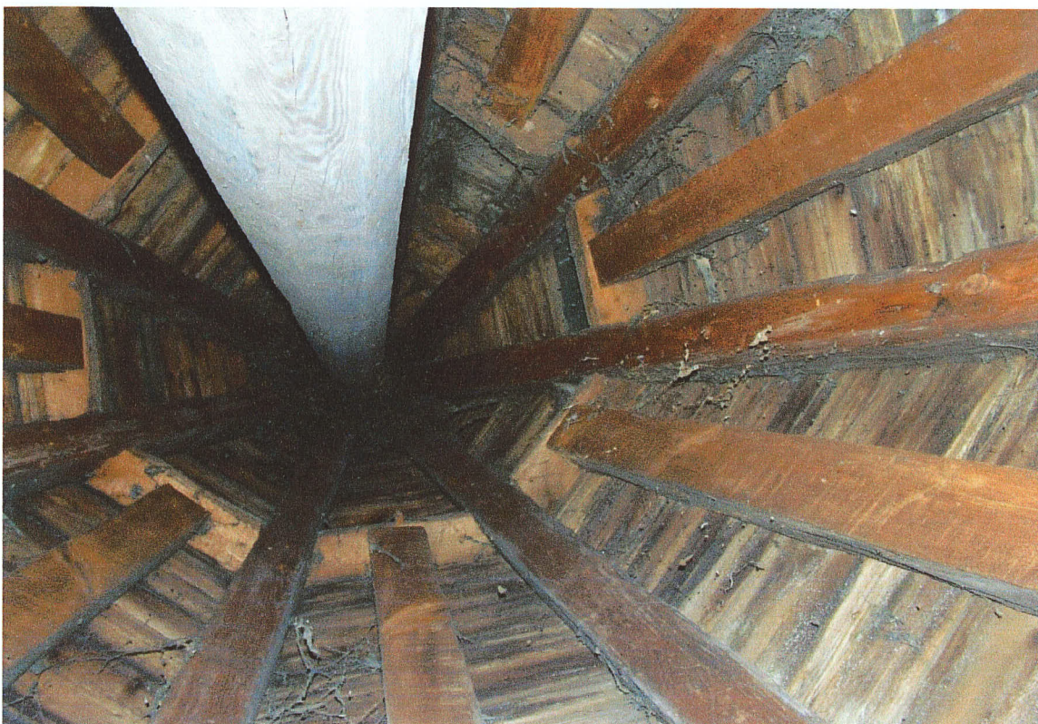
7.29. więźba szczyt hełmu, fot.69, fot.70
