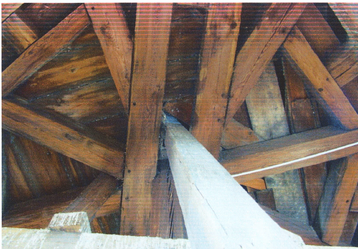
7.27. więźba konstrukcja helmu, fot.65, fot.66
