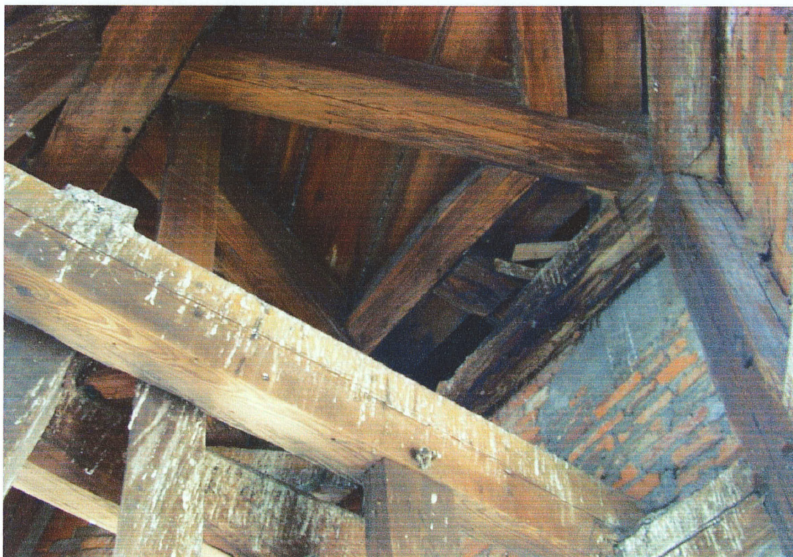
7.26. konstrukcja podtrzymująca dzwon, fot.64.
