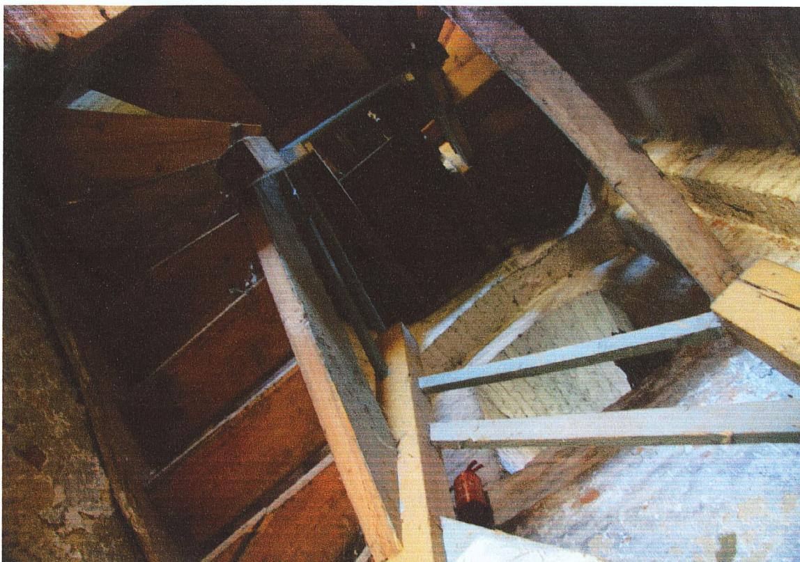
7.21. drewniane schody zabiegowe, fot.55, fot.56
