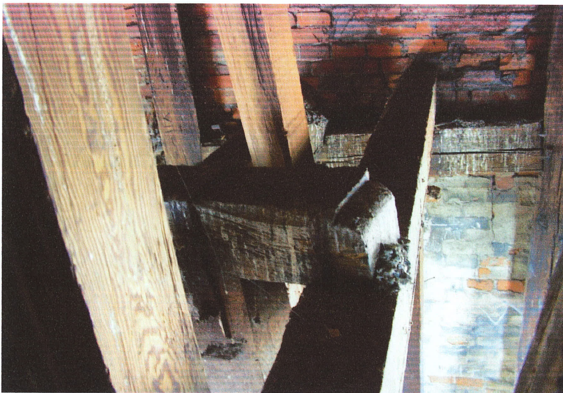
7.28. więźba hełmu, elementy mocujące, fot.67, fot.68
