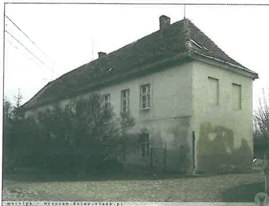
Dawny dwór Gądowski od strony wjazdu na podwórze
