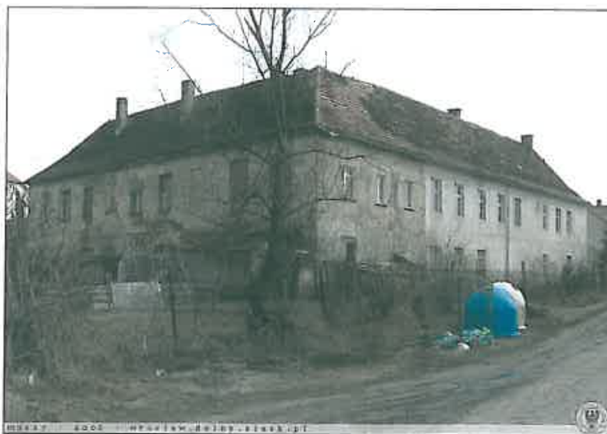
Gądów - częściowo zamieszkanym budynku nr 17, XVIII wieczny dwór.
