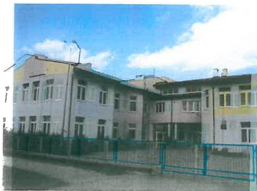
Budynek Szkoły Podstawowej
