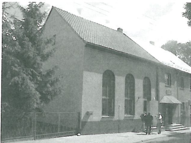
Zdj nr 1. Świetlica wiejska w Skalce.
