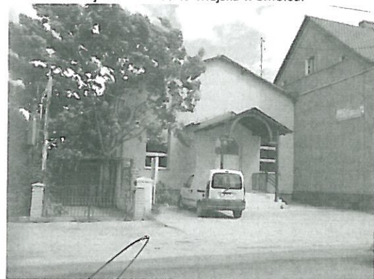
Zdj nr 14. Świetlica wiejska w Pietrzykowicach.
