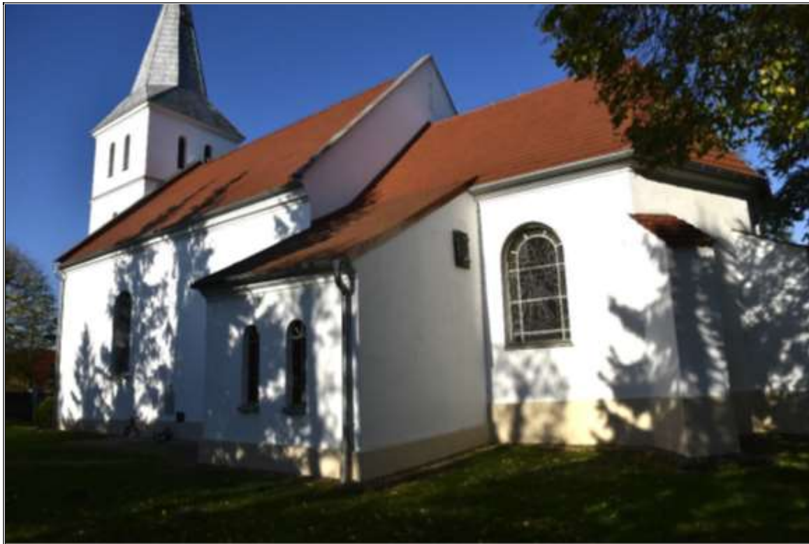
Rysunek 69. Kościół par. pw. Wniebowzięcia NMP w zespole kościelnym w Zachowicach
